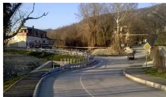
Приведение дорожного покрытия в надлежащее состояние
