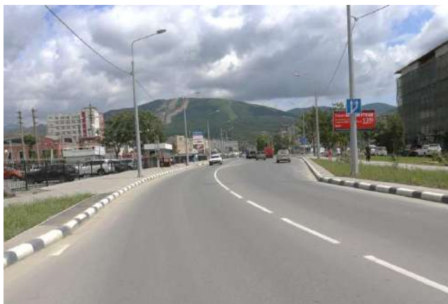
Реконструкция дорожного покрытия
