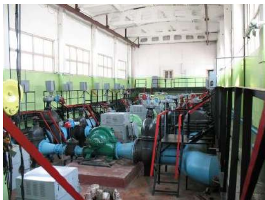
Выполнены работы по техническому перевооружению ПС-7
